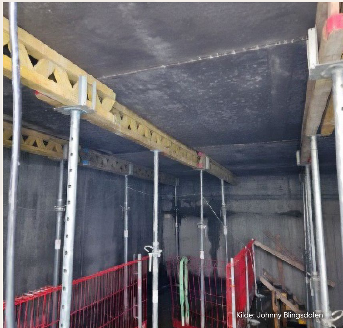
ILLUSTRASJON 2: Midlertidig understøttelse av plattendekker i en bolig under produksjon.
