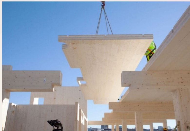
ILLUSTRASJON 8: Et prefabrikkert element monteres på byggeplass. Kilde: SPLITKON/Foto: HasleTre v/Moritz Groba
