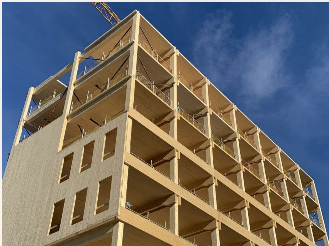
ILLUSTRASJON 7: Bæresystem i tre er basert på kombinert bæring med massivtreplater i dekke og vegger og limtre i søyle og bjelker.
